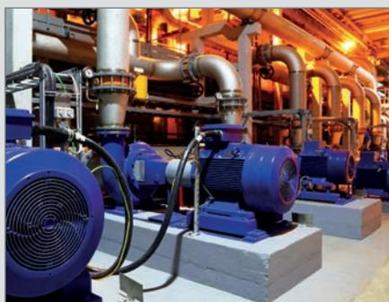
工業用機器設備: 減振墊/腳和基礎隔振產品降低機器的振動
